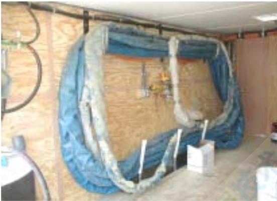
图 12、单台主机的管道缠绕方式
