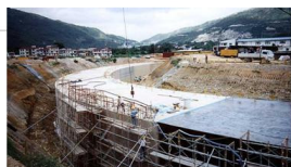
香港地铁隧道/外防水(聚脲)工程 美国 Gusmer/SPI 1818/D7 喷枪
