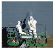
美国波士顿地铁 隧道防水工程
