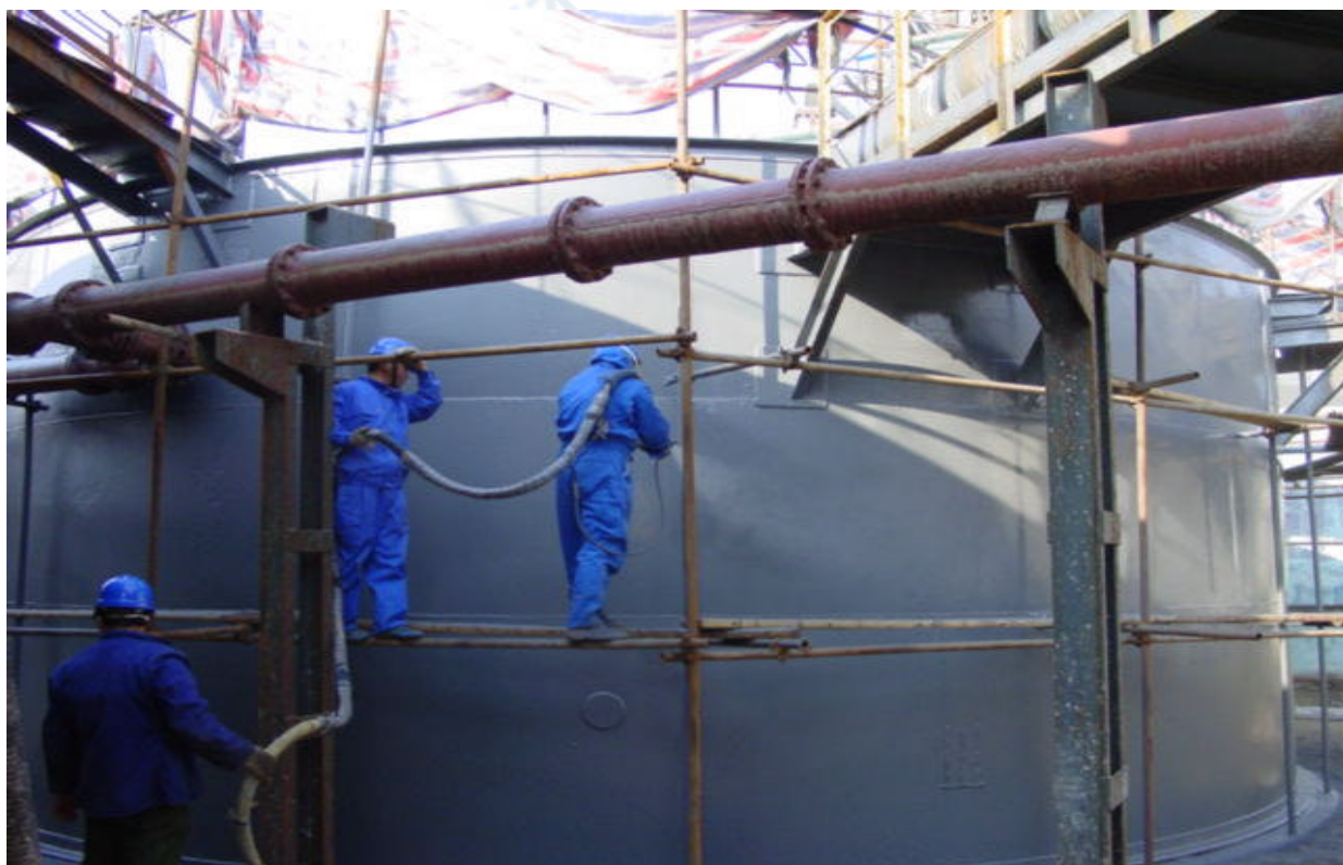
图 5 SPUA 技术施工罐体侧壁
