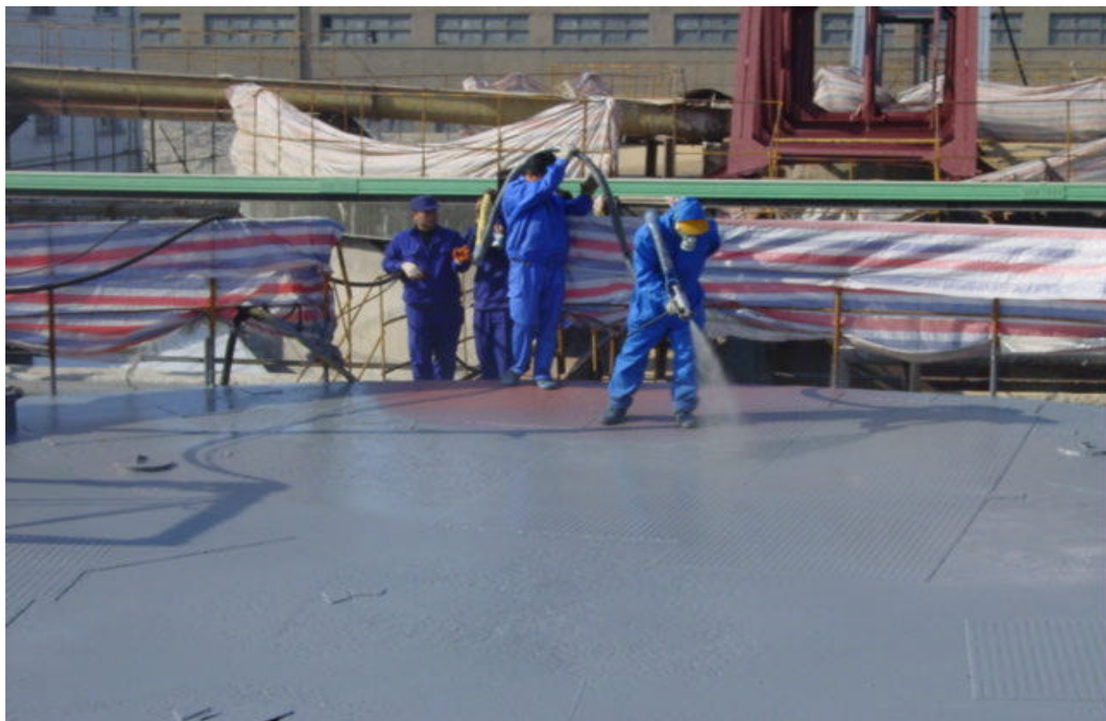
图 4 SPUA 技术施工罐体顶部
