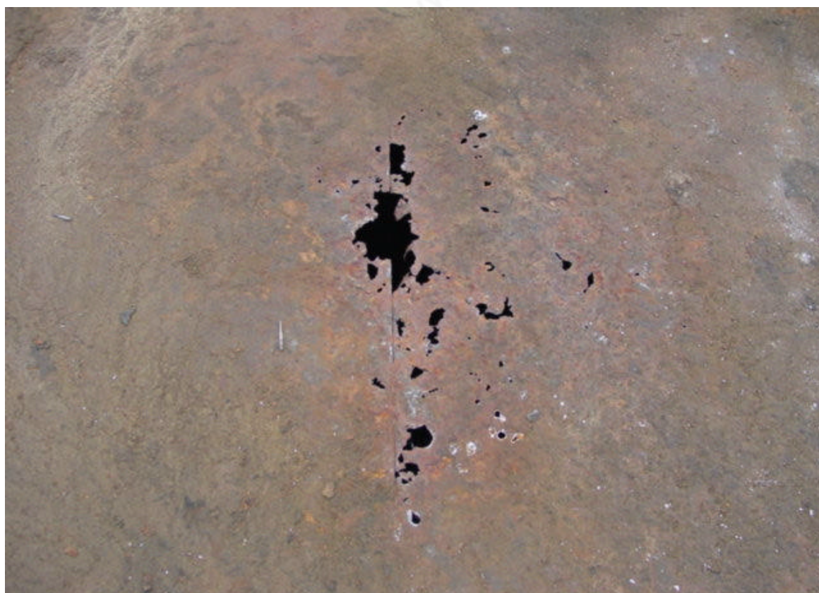
图 3 被腐蚀损坏的贮罐钢板
