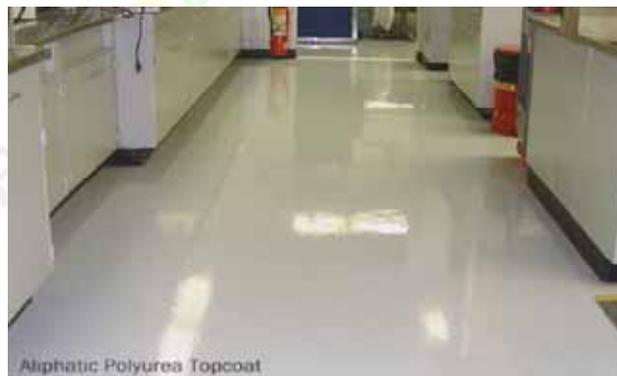
图 3 聚天门冬氨酸酯地坪涂料施工效果
