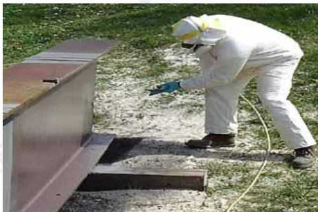
图 4 白色聚天门冬氨酸酯 SPUA 材料施工场面
